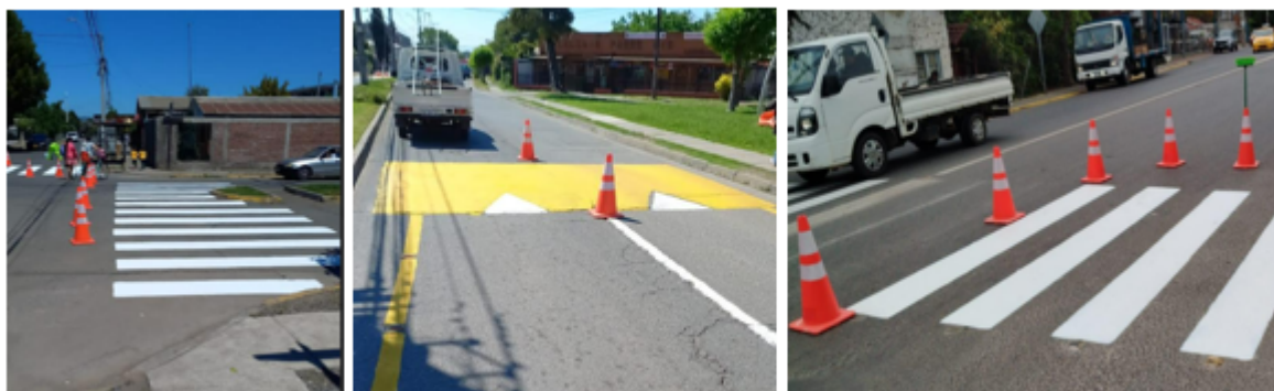
Ilustración 3 Fotografías trabajos realizados de demarcación
